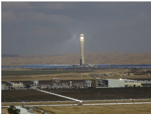
Solarversuchsfeld in der Wüste —30.000 Spiegel auf eine Punkt
